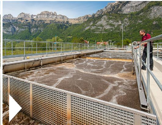
**Sandfang.** Im Sandfang werden gut absetzbare Stoffe wie Sand und Kies beseitigt sowie aufschwimmende Fette und Öle entfernt.
