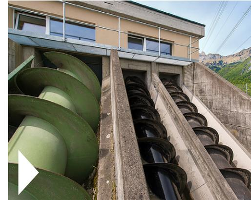
**Hebwerk.** In der ARA angekommen wird das Abwasser mit grossen Schneckenpumpen um mehr als 5 Meter in die Höhe befördert. Danach fliesst das Abwasser im freien Gefälle durch die ganze ARA und schliesslich gereinigt in die Seez.
