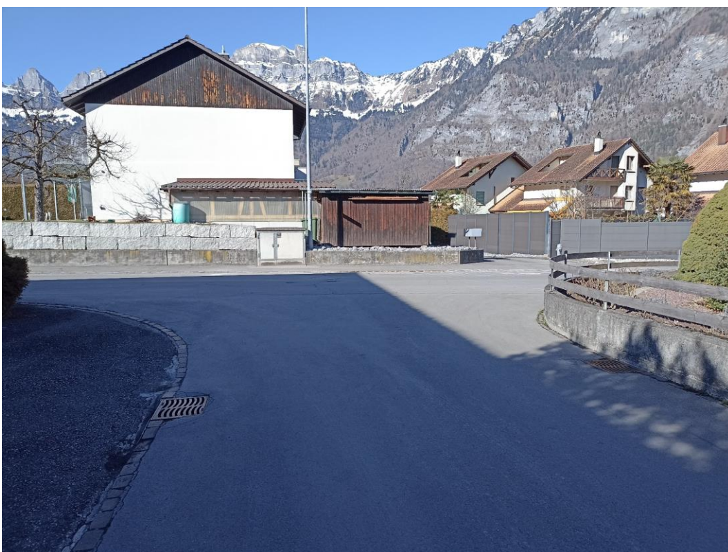
Abb. 11: Unübersichtliche Knotensituation Eichenstrasse-Ulmenstrasse
