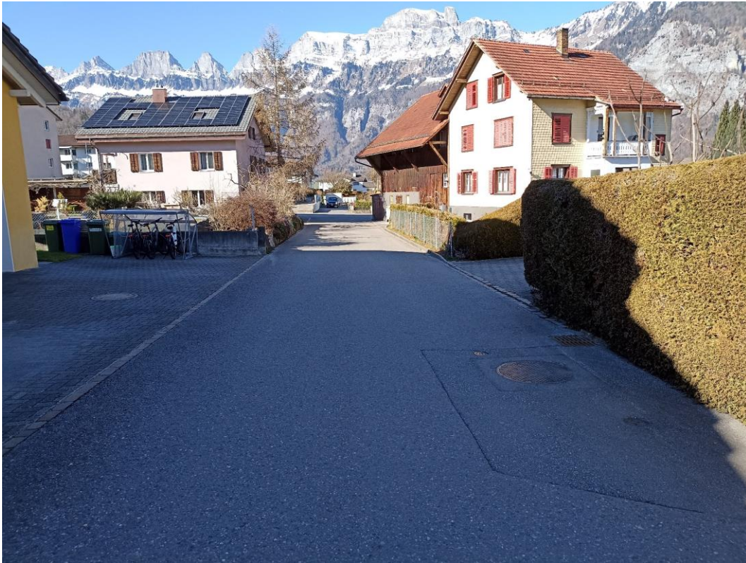
Abb. 28: Gulmenstrasse; enger Strassenraum und eingeschränkte Sicht bei verschiedenen Grundstückzufahrten
