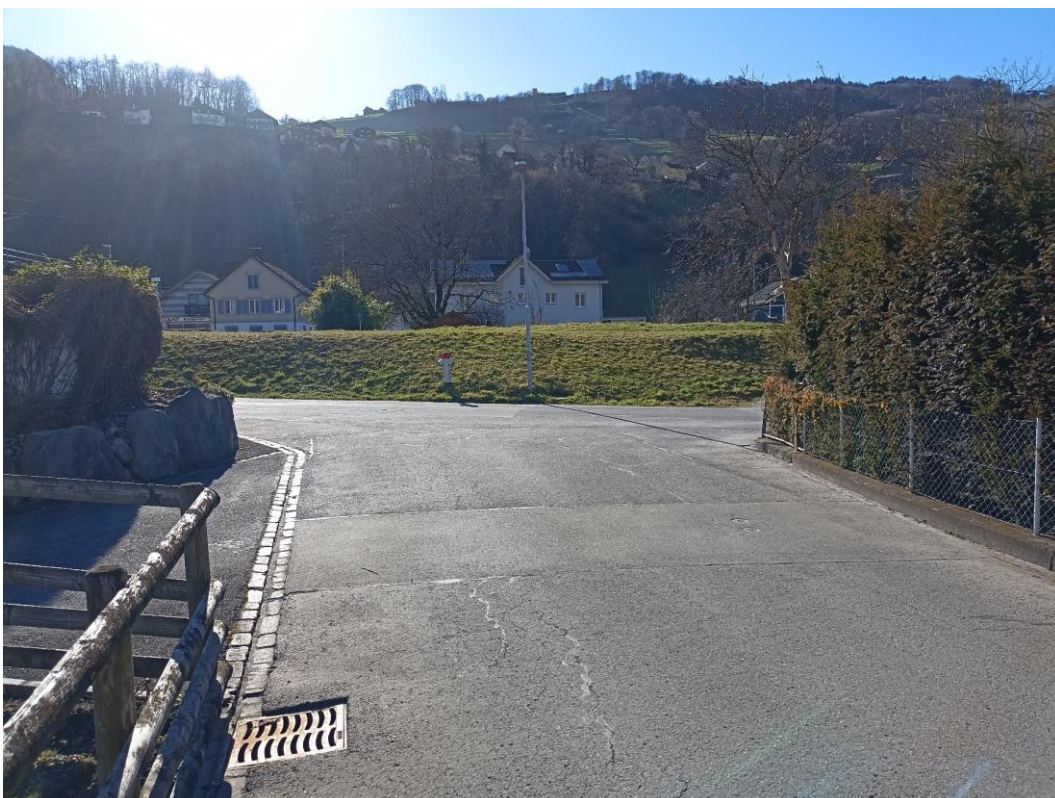
Abb. 14: Unübersichtliche Knotensituation Hösslstrasse - Dammstrasse
