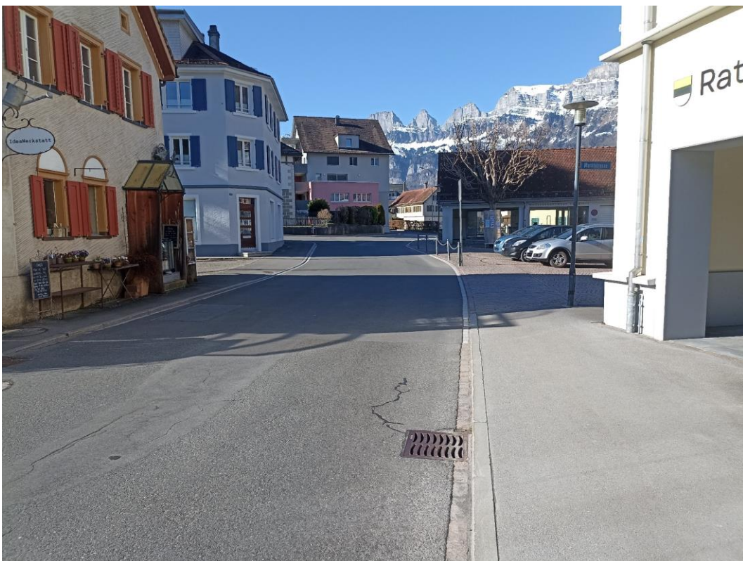
Abb. 31: Unübersichtliche Knotensituation Eisenherrenstrasse – Marktstrasse
