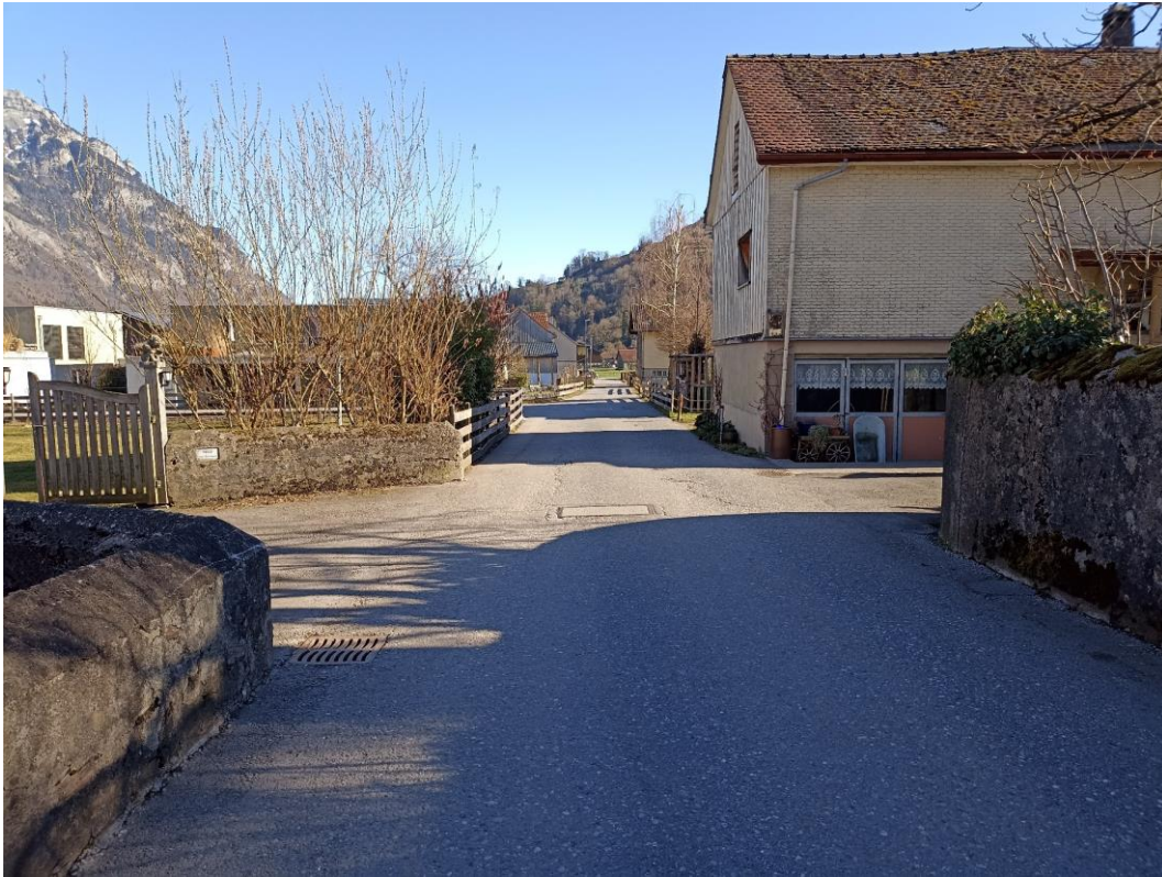
Abb. 53: Feldstrasse; enger Strassenraum mit eingeschränkter Sicht bei verschiedenen Grundstückzufahrten
