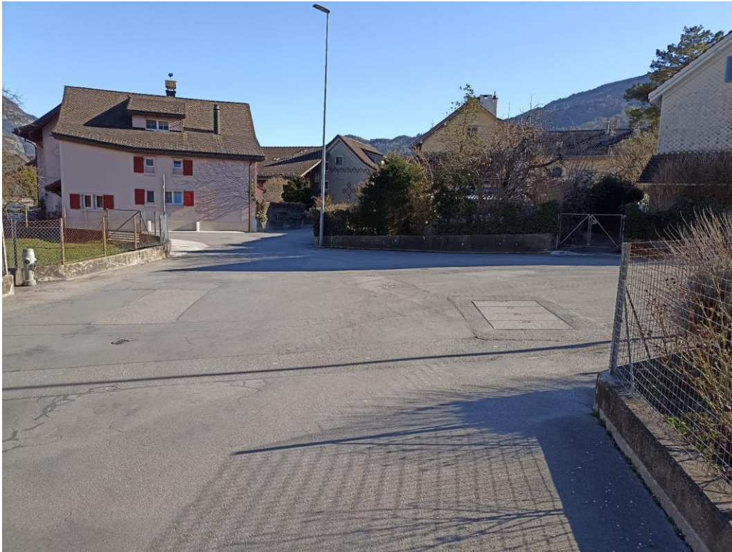
Abb. 30: Unübersichtliche Knotensituation Ganischastrasse – Hösslstrasse – Guschastrasse
