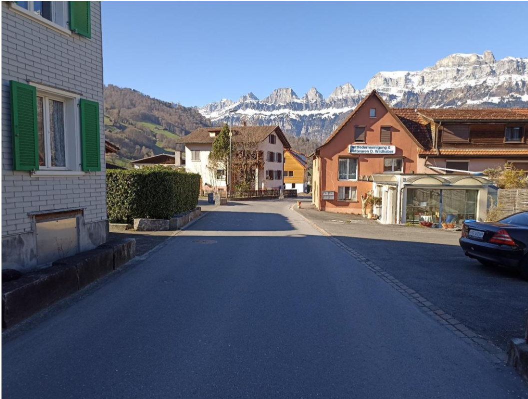
Abb. 15: Schlisstrasse; enger Strassenraum und eingeschränkte Sicht bei verschiedenen Grundstückzufahrten
