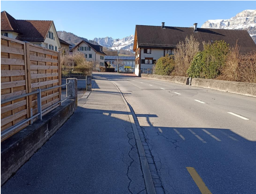
Abb. 51: Unterdorfstrasse; Private Zu- und Wegfahrt mit eingeschränkter Sicht
