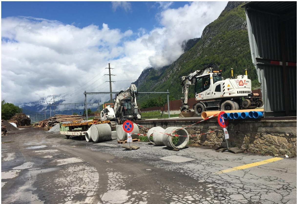
Abbildung 18: km 2.60 Güterrampe, Blickrichtung Flums, 2022 G+K (18)
