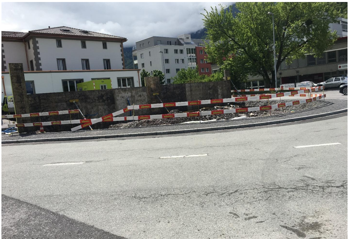
Abbildung 17: km 2.61 Mündung Grofstrasse, Bahnhofstr., Blickrichtung Südost, 2022 G+K (17)
