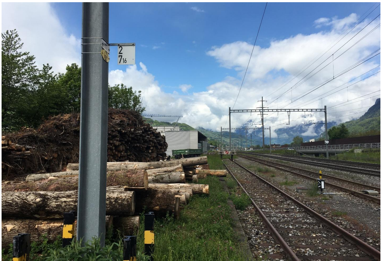
Abbildung 7: km 2.71 Mast 33, Blickrichtung Flums, 2022 G+K (7)
