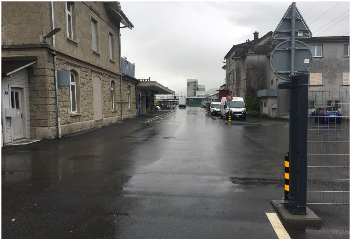
Abbildung 3: km 9.74 Bahnhofsgebäude, Blickrichtung Südost, 2022 G+K (4)
