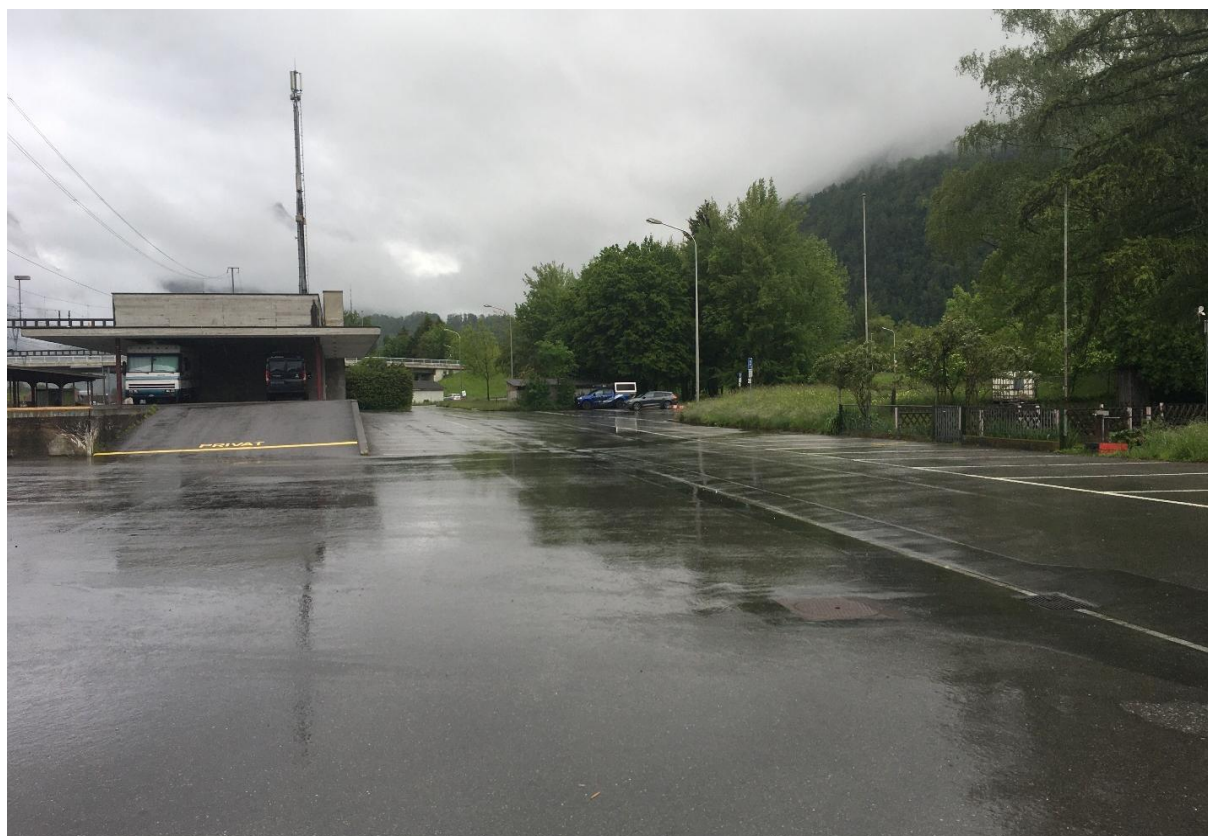
Abbildung 5: km 30.62 Rampe, Blickrichtung West, 2022 G+K (6)
