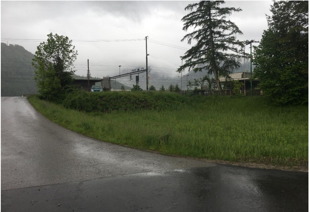
Abbildung 13: km 30.62 Wegkreuzung Blick auf Bahnhof, Blickrichtung Südwest, 2022 G+K (14)
