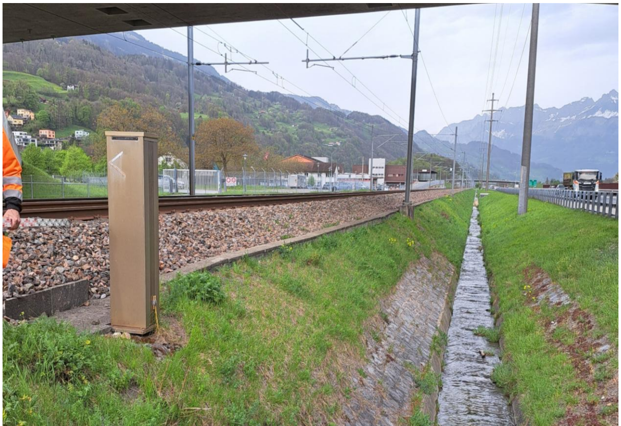
Abbildung 8 km 3.48, Linie 890, Blickrichtung Nordwest, 2024 AFRY (M3)
