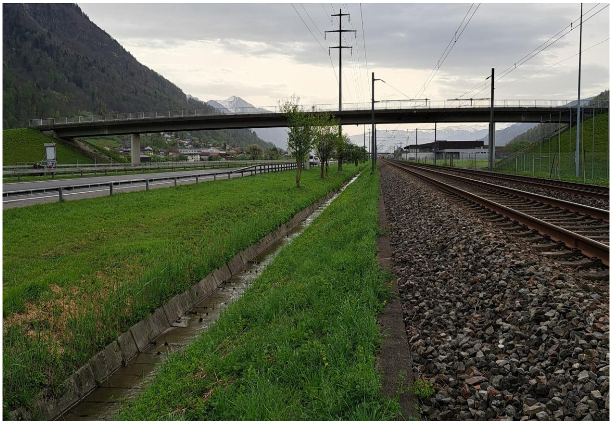
Abbildung 10: km 4.30, Linie 890, Blickrichtung Südost, 2024 AFRY (M5)
