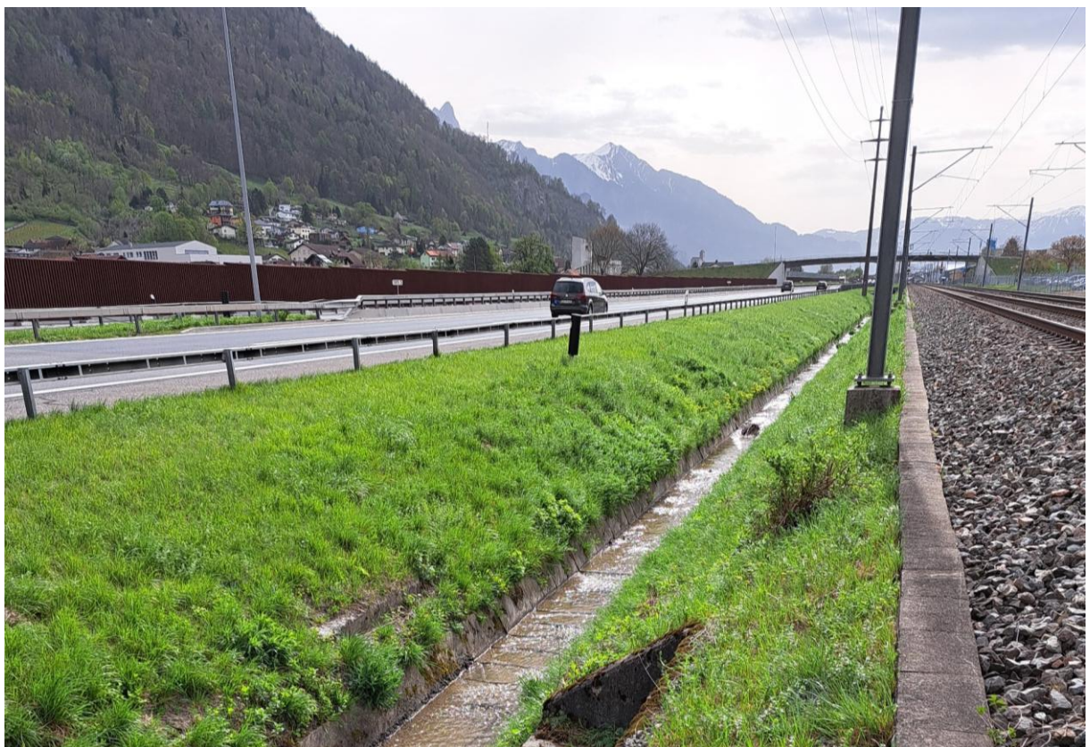
Abbildung 9: km 3.85, Linie 890, Blickrichtung Südost, 2024 AFRY (M4)
