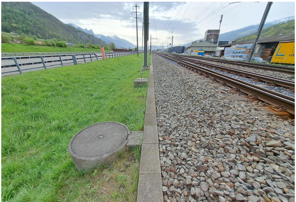
Abbildung 7: km 3.21, Linie 890, Blickrichtung Südost, 2024 AFRY (M2)
