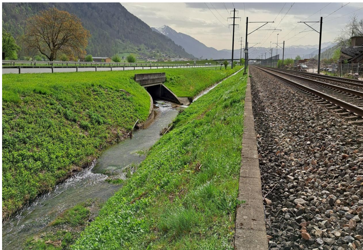
Abbildung 11: km 4.74, Linie 890, Blickrichtung Südost, 2024 AFRY (M6)
